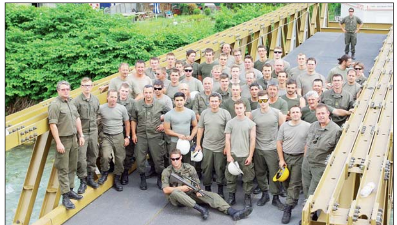
Einem "klassischen Pionierthema" widmet sich bei der "Schutz 2014" die Miliz. Die Pionierkompanie des Militärkommandos Tirol errichtete zusammen mit dem Pionierbauzug eine 55 Tonnen schwere Stahlbrücke in Zell am Ziller. Die so genannte D-Brücke hat eine Länge von 27 Meter und eine Tragkraft von 70 Tonnen. Der Aufbau dauerte drei Tage.
