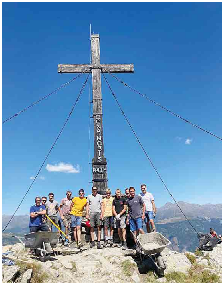
Freiwilligen Helfer der Sockelsanierung Text und Fotos: Kameradschaftsbund Sillian und Umgebung
